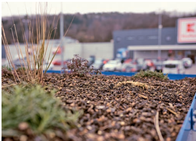
|| Das Dach der neuen Haltestelle am Kaufland ist begrünt.
